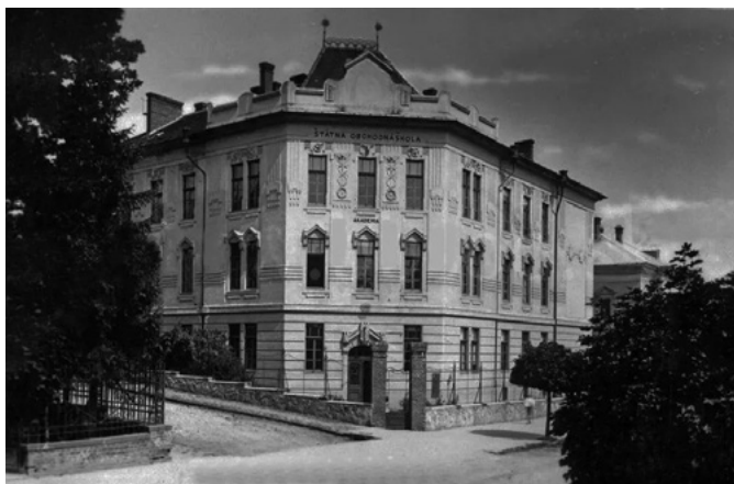
Škola na Skuteckého ulici č. 11
