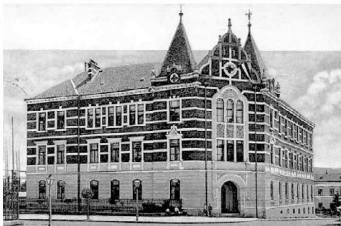
Škola na Skuteckého ulici č. 8
