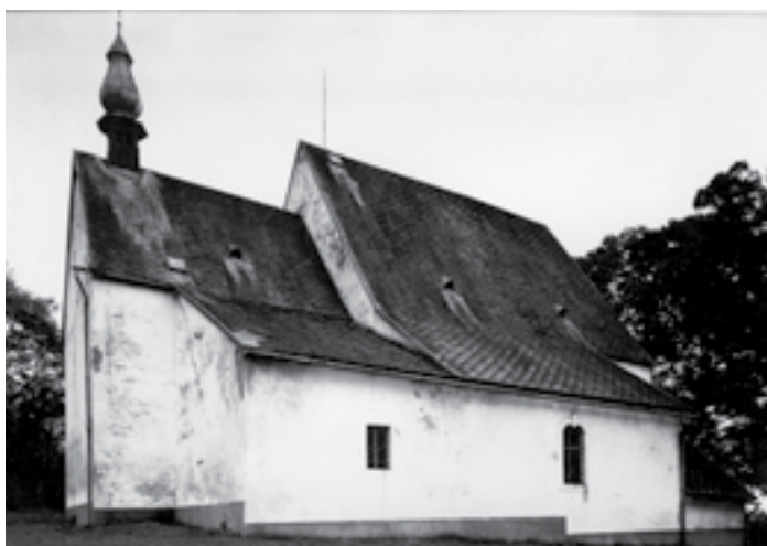
Baroková podoba kostola z 2. polovice 18. storočia, pohľad na S-V stranu s vežičkou – lucernou nad presbytériom. Fotografia: N_4244_1 - N_4244_1.
