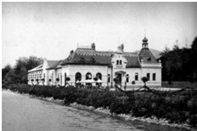
Pôvodná budova Parných a vaňových kúpeľov pod Urpinom
